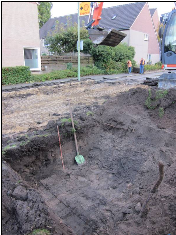
Overzicht kijkgat, gezien richting het noorden
